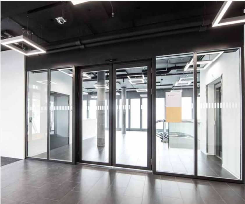
**Im Alltag** bieten automatische Schiebentüren mit Rauch und Brandschutz die komfortablen Vorteile von Automatikentüren: berührungslose, hindernisfreie Durchgänge.
