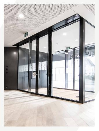
Die Gilgen Profilsysteme PSXP und PST (thermisch getrennt) RC2/RC3 bieten den optimalen Einbruchschutz.
